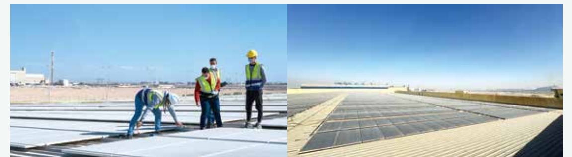
巨石埃及建设光伏发电项目
